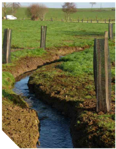
Restauration d'un cours d'eau
