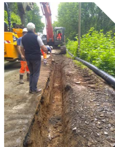
Chantier de renouvellement de canalisation d'eau potable à Bobital
