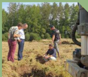
← Chantier de renaturation d'un cours d'eau à Lanrelas, près de Broons
